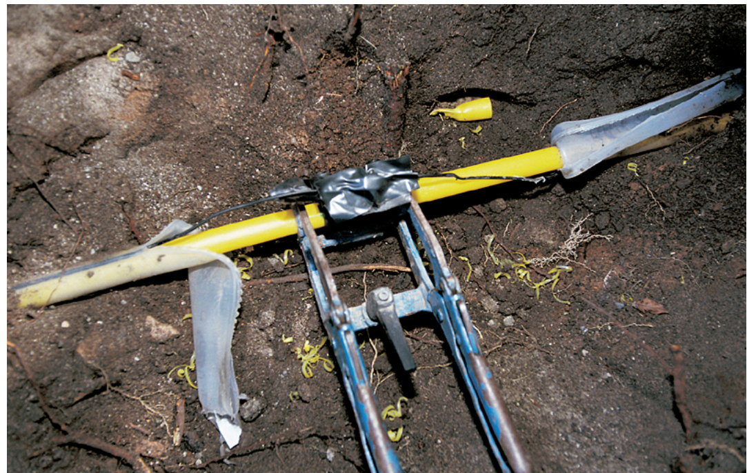
Billede: Klemning af gasrør efter overgravning.
