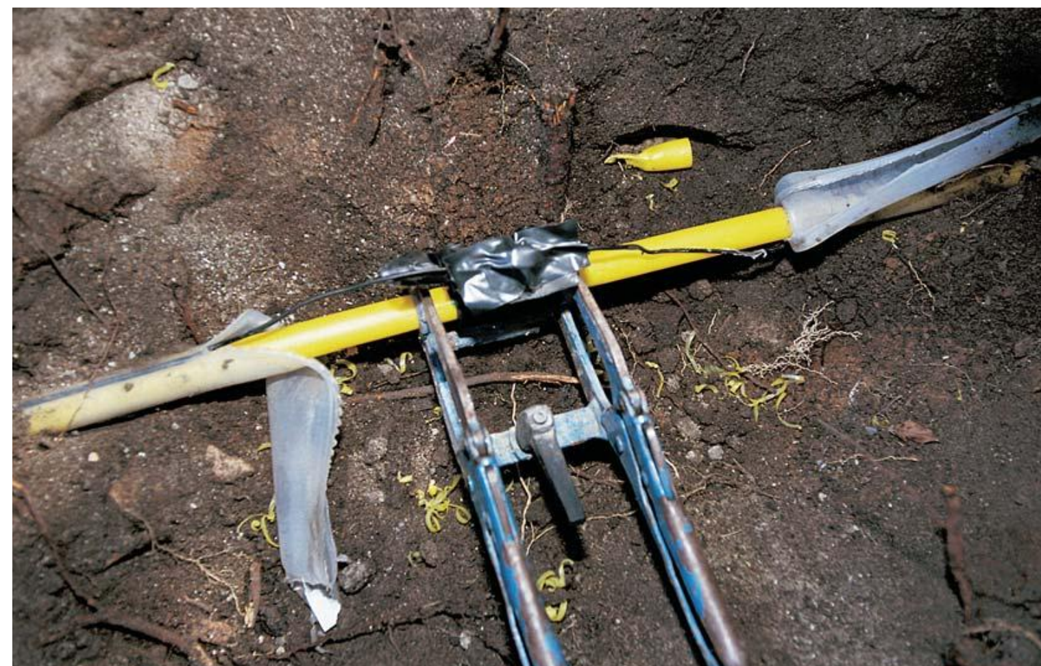
Billede: Klemning af gasrør efter overgravning.
